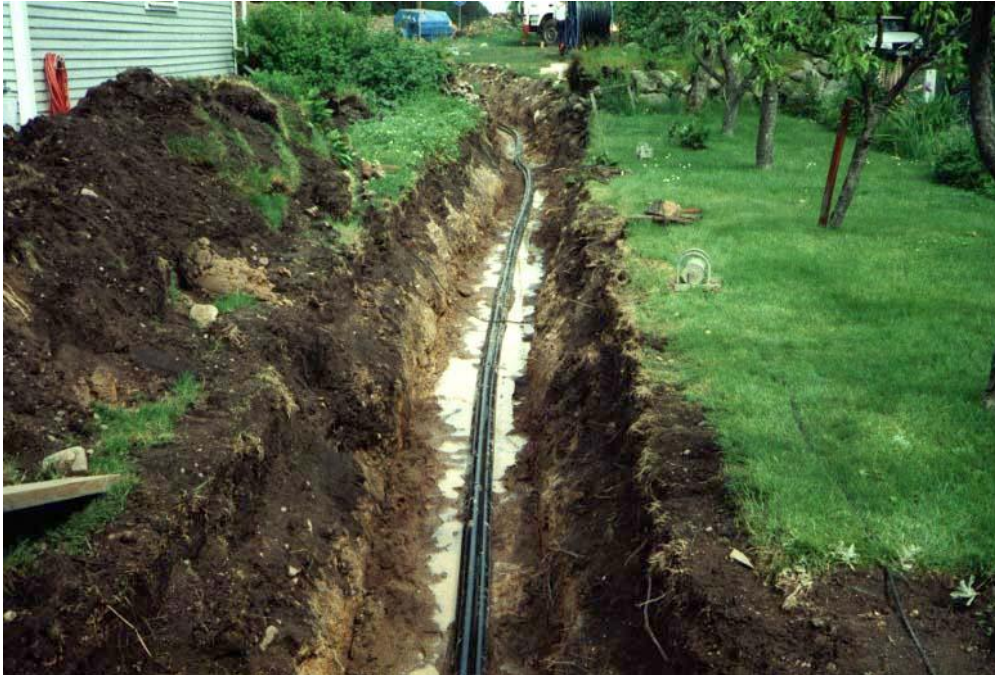
Vattnet samlas kring ledningen som grävts ner på lott 36.
